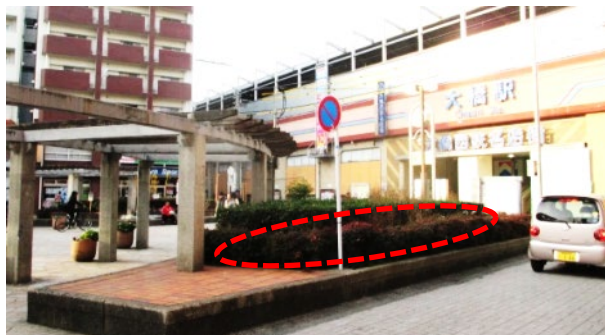
大橋駅西口広場
